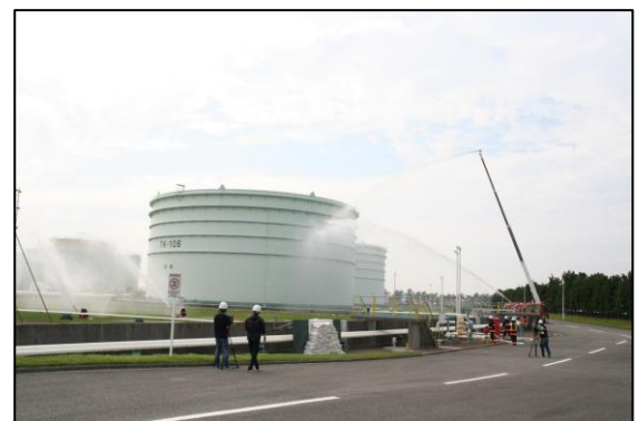
タンクへの冷却散水
