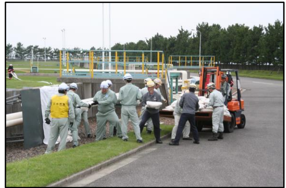
防油堤亀裂部への土嚢構築
